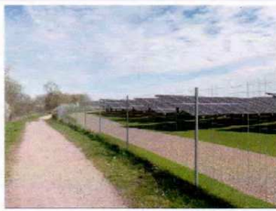
Figure 135. Photo de vue d'ensemble du projet depuis le quartier GDF à l'ouest et au sud-est, avec la centrale et le photovoltaïque.
